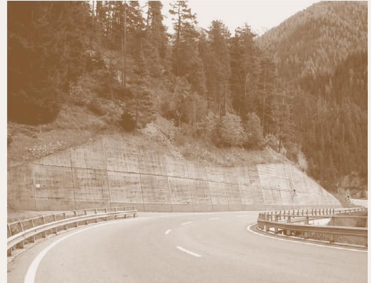
Les contours arbitraires, les mauvaises finitions des surfaces et traces de salissures expliquent la mauvaise réputation du béton. À l'inverse, le coffrage du mur à l'entrée du tunnel de Calfreisen, avec ses lignes propres et simples, ne laisse rien à désirer.
