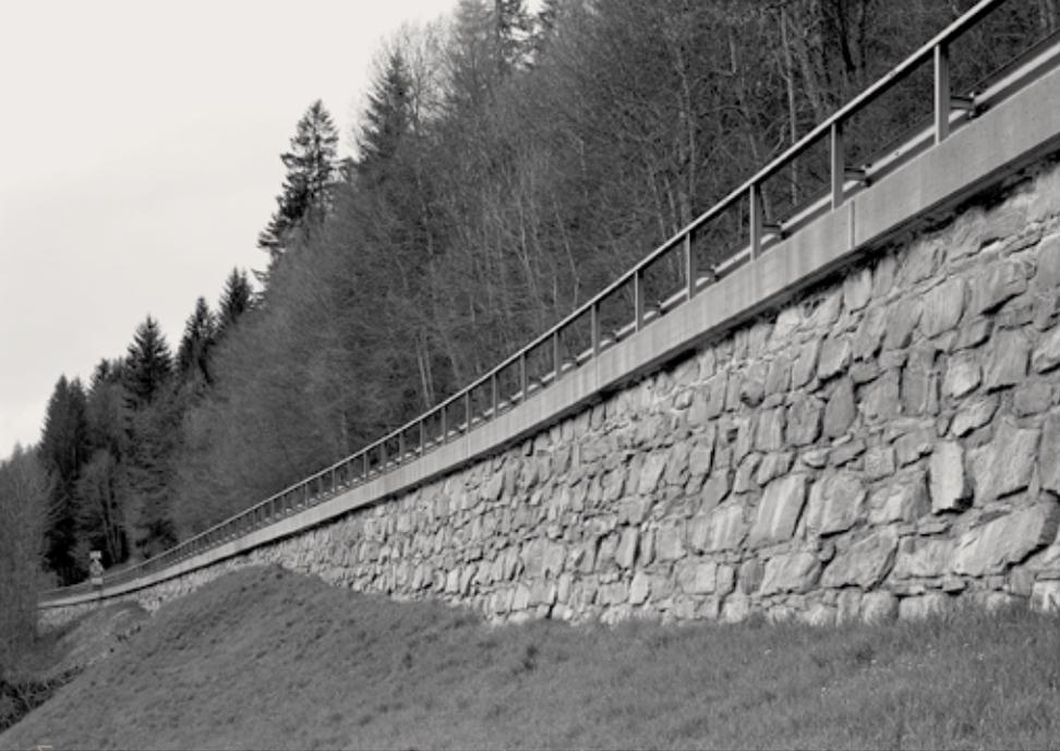
Mur à Mezzaselva composé de gros blocs posés par la machine et remplissage à la main par des pierres plus petites suivant une superposition de lignes.
