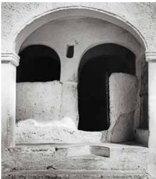
Éléments d'arcature sur une place publique.
