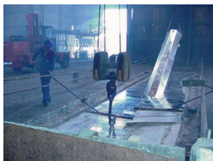
La galvanisation de l'acier : un bain de zinc à 450°. Usine SNG à Carquefou (44).
