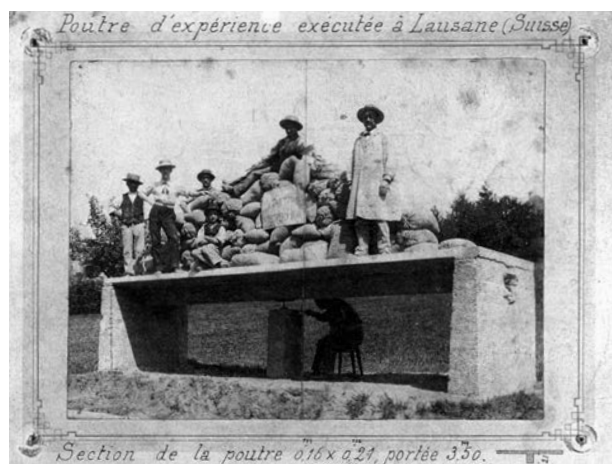
77 ▷ Test de résistance d'une poutre Hennebique exécuté à Lausanne (1893).
