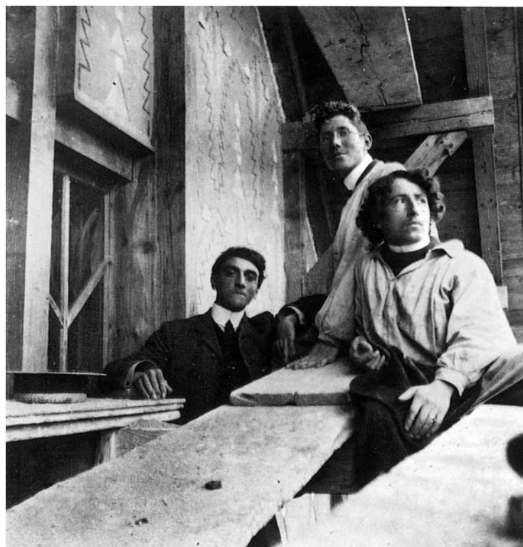
2 ▷ Octave Matthey : Charles-Édouard Jeanneret et Louis Houriet travaillant sur l'ornementation en sgraffite des façades de la villa Fallet à La Chaux-de-Fonds (1907).
