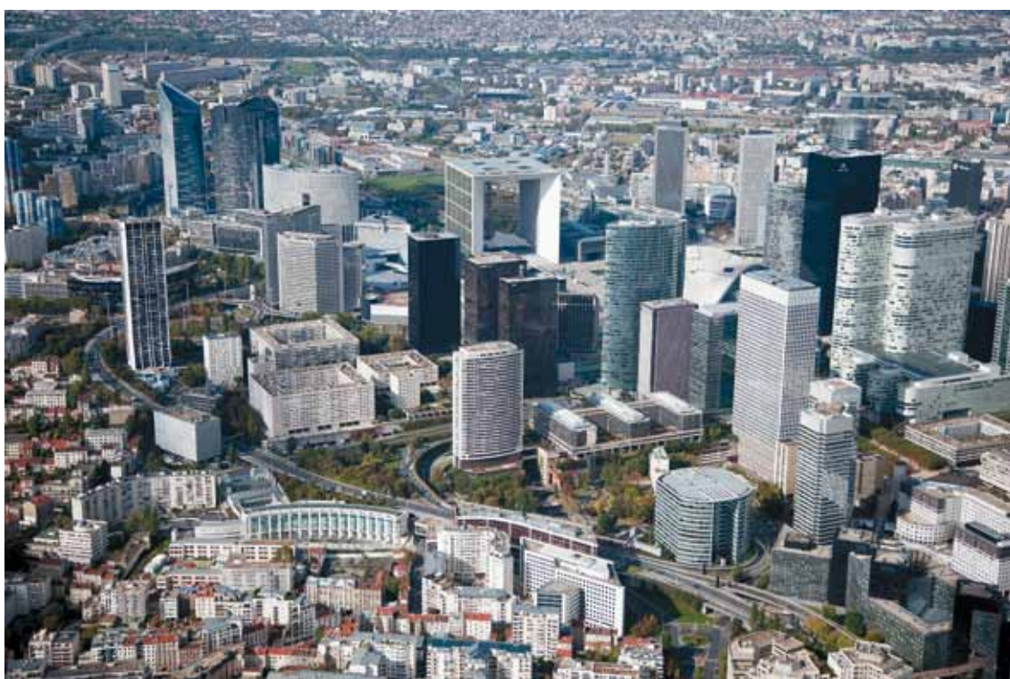
La Défense vue depuis le sud-est.
