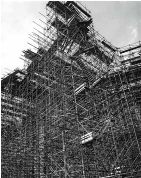
Le chantier du Cnit et ses échafaudages, ca 1957. ● Archives Épad.
