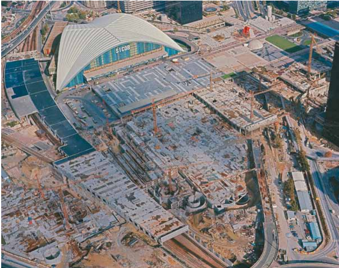
Le chantier «à l'abandon», en 1976. ● Photographie : Jean Rabier. Archives Épad.
