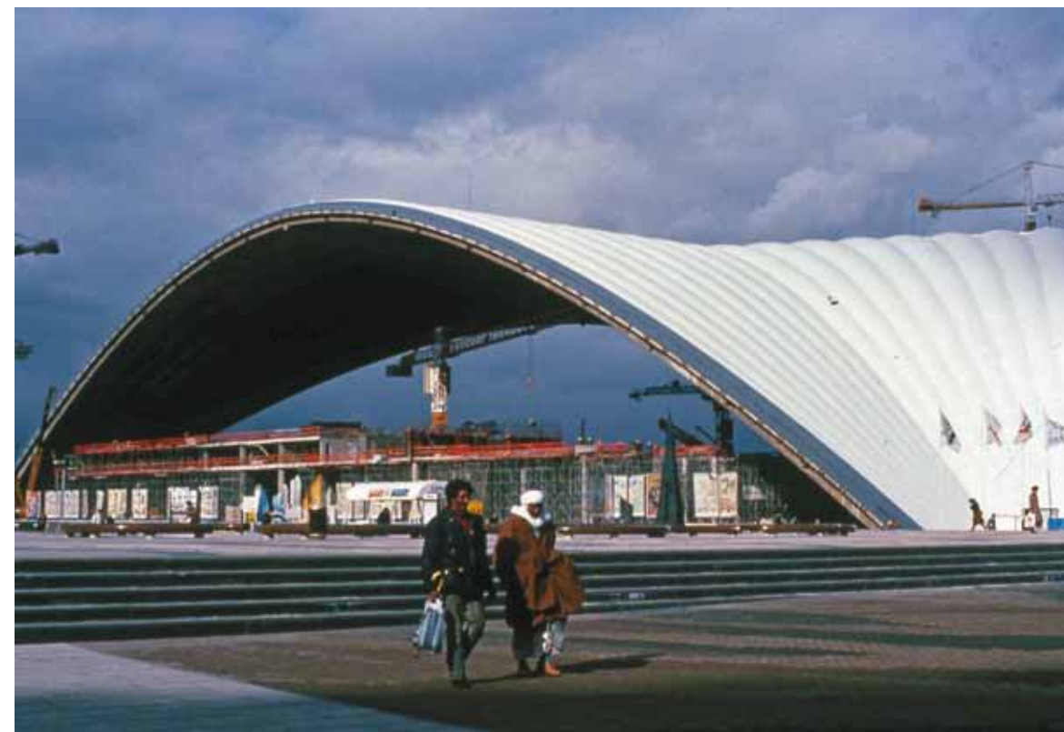
La coque du Cnit vide lors des travaux de rénovation en 1988-1989. © Archives Épad.
