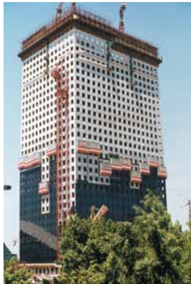
La tour Fiat en construction, juillet 1974.
