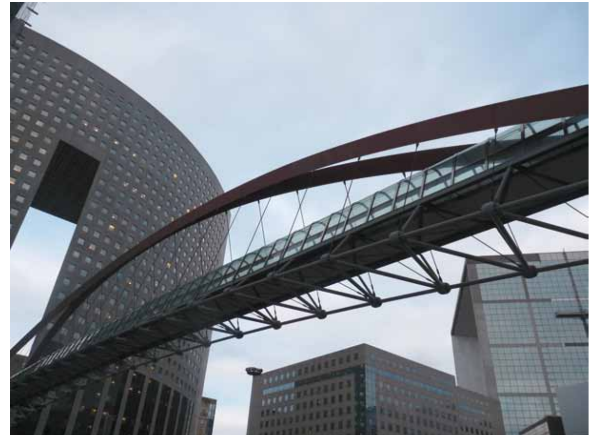
Passerelle piétonne conçue par Kisho Kurokawa et Peter Rice (1994) qui relie les tours Kupka (architectes : M. Andrault et P. Parat, 1992) et la tour Pacific (architecte : K. Kurokawa, 1992). Archives Épad.
