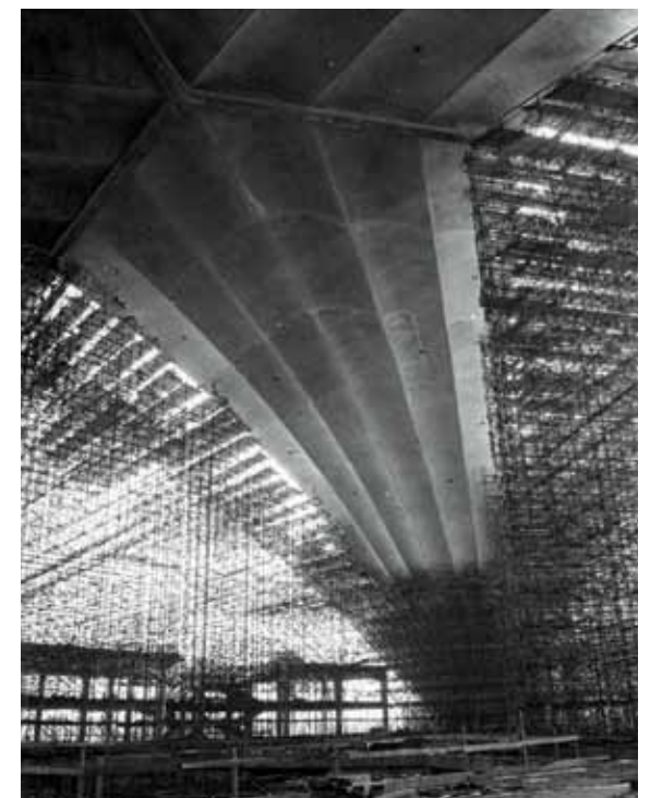
□ L'une des trois assises du Cnit en chantier. ○ Archives Épad.
