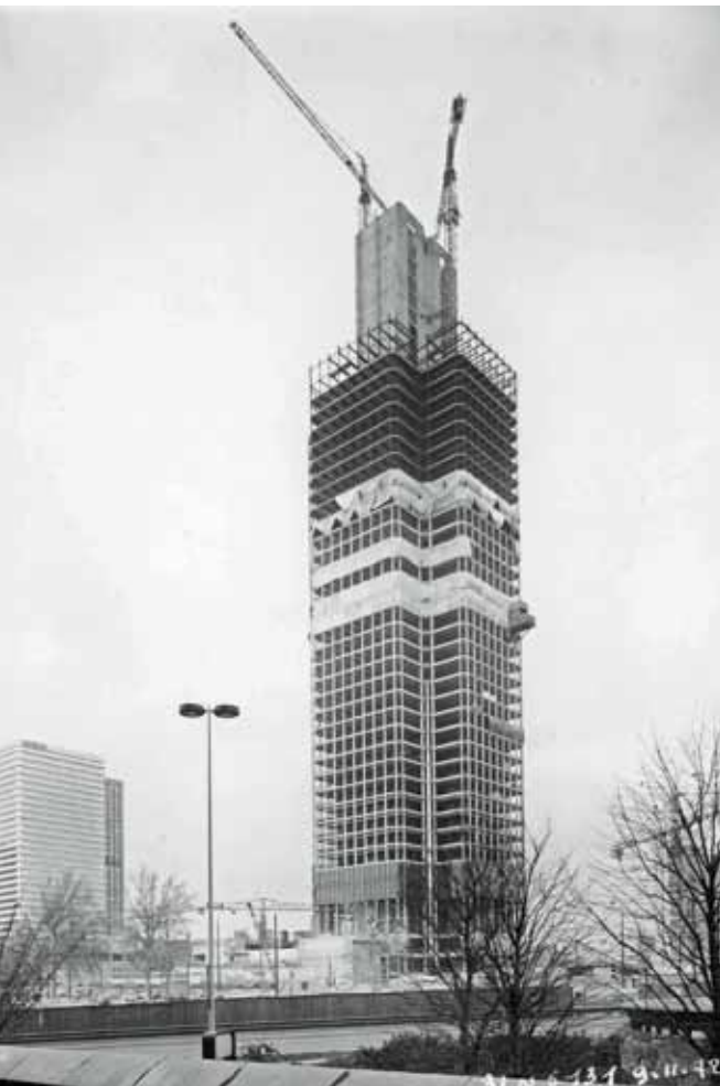
Montage de la charpente métallique de la tour Gan, 1974 ; architectes : Max Abramovitz, Wallace Harrison et associés. Archives Épad.
