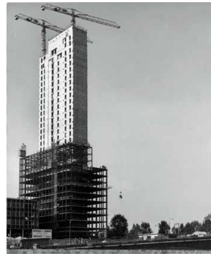
Montage de la charpente métallique cernant le noyau en béton armé de la tour Nobel ; architectes : Jean de Mailly, Jacques Depussé ; ingénieur : Jean Prouvé ; 1966. © Archives Épad.
