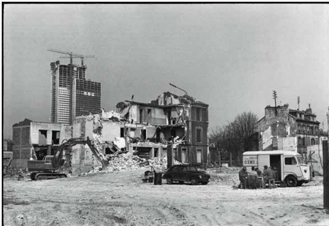
Courbevoie, construction de La Défense et démolition des bâtiments expropriés (1969).
