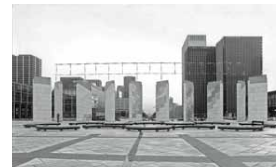
Arcatures en partie réalisées, ca 1981. Architecte : Émile Aillaud. © Archives Épad.
