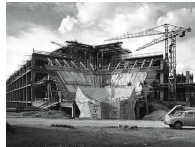
Le chantier du Cnit, mise en place des coffrages des points d'appui, 1957. Architectes : Robert Camelot, Jean de Mailly, Bernard Zehruss ; ingénieur : Nicolas Esquillan. © Archives Épad.
