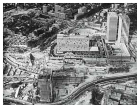
La tour Esso au centre, photo aérienne du chantier de La Défense, ca 1967. ● Archives Épad.
