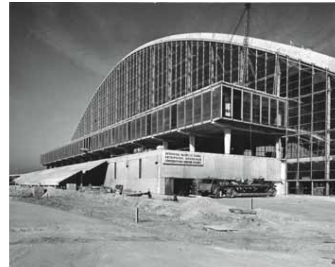
L'une des trois façades du Cnit en voie d'achèvement, 1958. ● Archives Épad.
