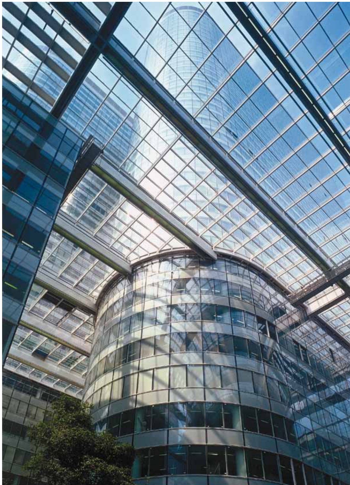
L'Atrium monumental de 44 m de hauteur, en acier et verre, du complexe Cœur Défense relie les deux tours jumelles et les trois bâtiments bas qui composent l'ensemble, 2001. Architecte : Jean-Paul Viguier.
